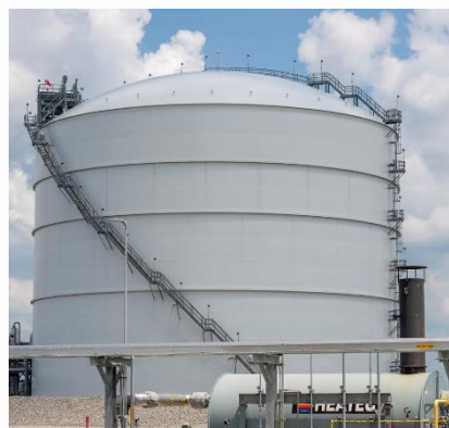
LNG PEAK SHAVING AMMONIA LIN / LOX
